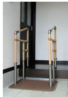
両手すり設置例
